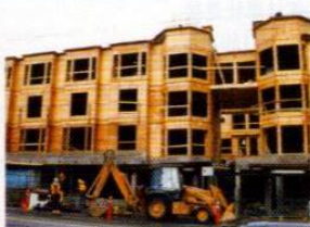
木结构与钢筋混凝土混合结构
