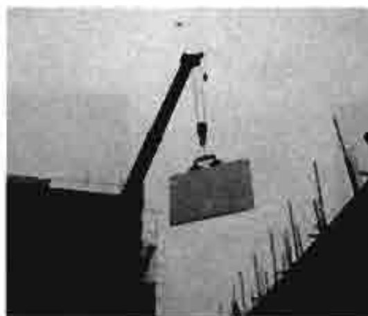
速成墙板吊装中
